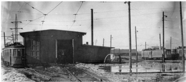
Ремонтный пункт «Восточный»
